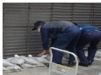
土嚢設置訓練（春日工事監理事務所）
