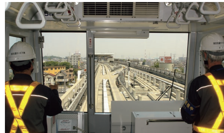
車両添乗による走行路点検 ▶
