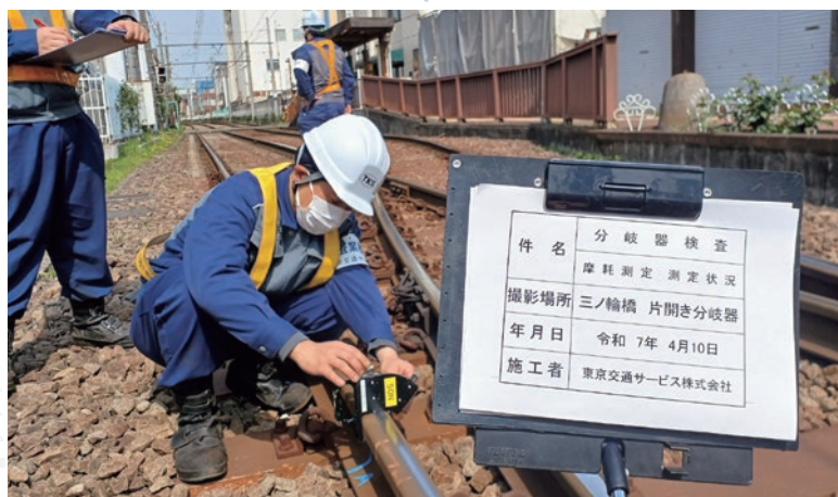
軌道の保守点検 ▶
