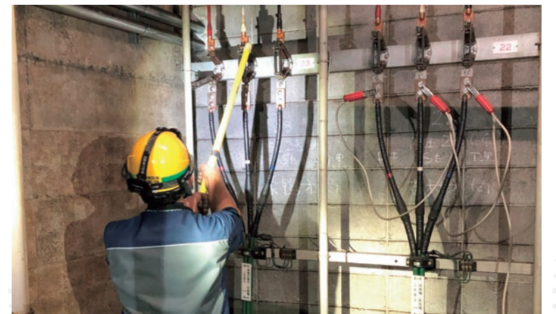
電気設備の工事監理 ▶
