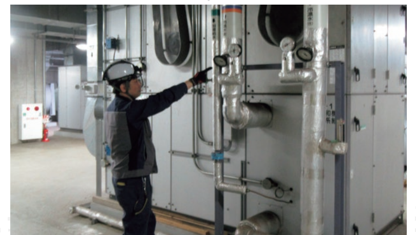
空調設備の保守点検 ▶
