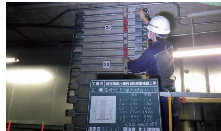
駅の柱の耐震工事監理 ▶
