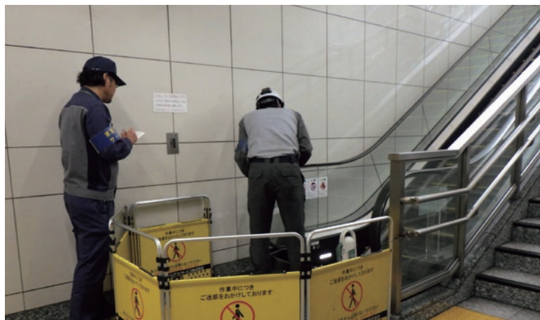
エスカレーターの保守点検 ▶
