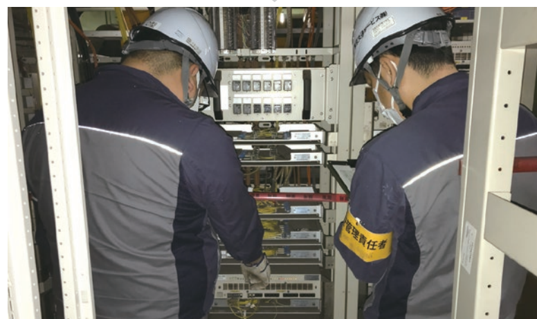
携帯電話設備の保守立会 ▶
