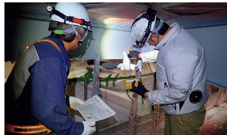
◀ 橋桁補修の工事監理
