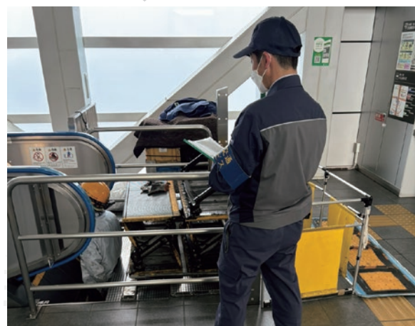
エスカレーターの保守点検 ▶
