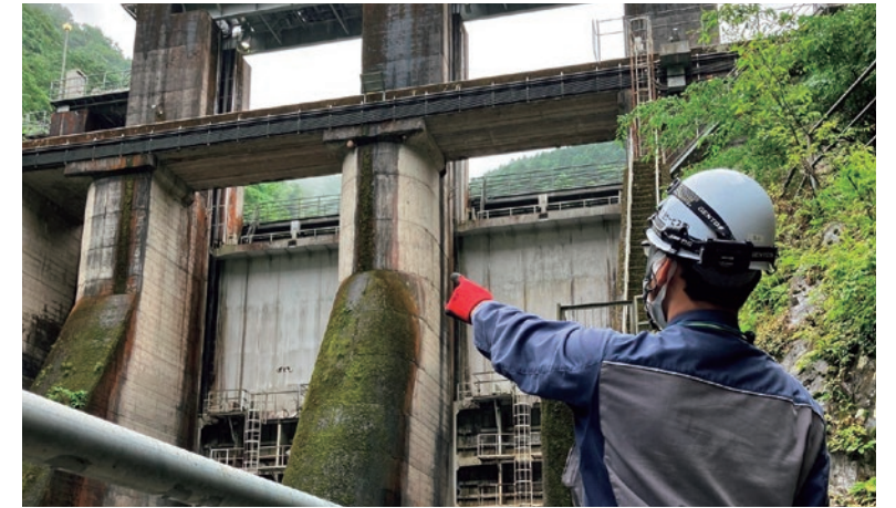
発電設備の保守点検 ▶
