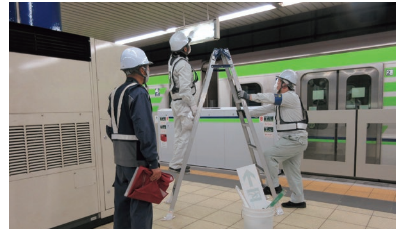
照明設備の点検清掃 ▶
